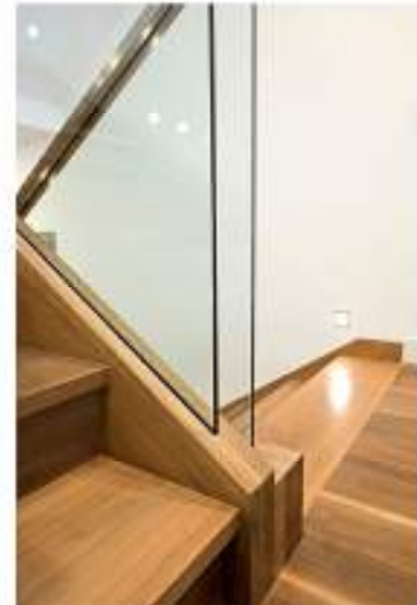
Built-in glass handrail in wooden base مسكة الزجاج المدمجة في قاعدة من الخشب
